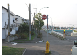
もみじ台通り歩道
